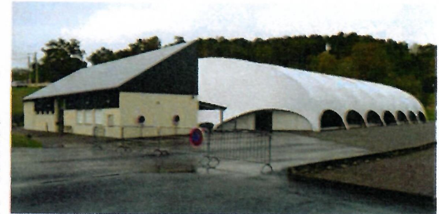
Pour les extérieurs, le parking permettant un accès facile et le réseau pluvial ont été refaits. ©JEAN-MARIE ESTOUP
