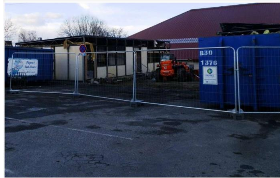
La démolition des deux préfabriqués libère l'espace nécessaire à l'extension de la salle des sports.
