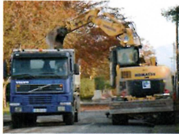
Les travaux vont reprendre pour deux mois, comme ici rue de la Plaine. © ALAIN GREGIO
