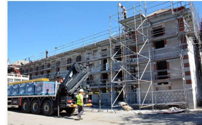
A l'école La Fontaine, les travaux seront terminés pour la rentrée scolaire 2018-2019.
