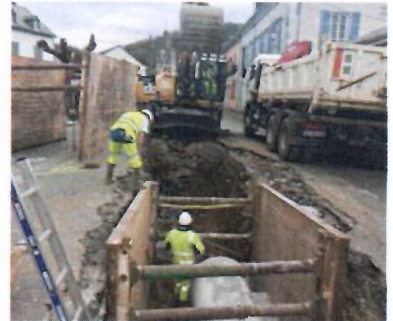
La place Camps est en plein chantier. Des déviations temporaires seront mises en place jusqu'à la fin des travaux. © GÉRARD CLOS COT
