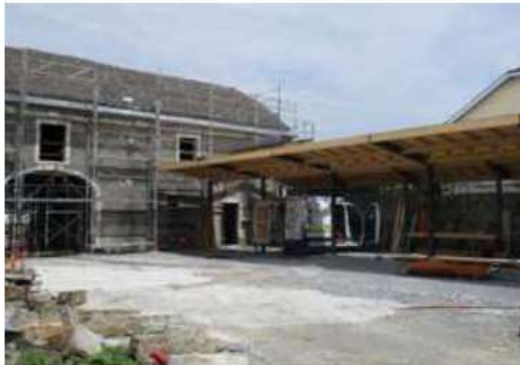
Le toit de la halle en voie de finition. © ALAIN GREGGI
