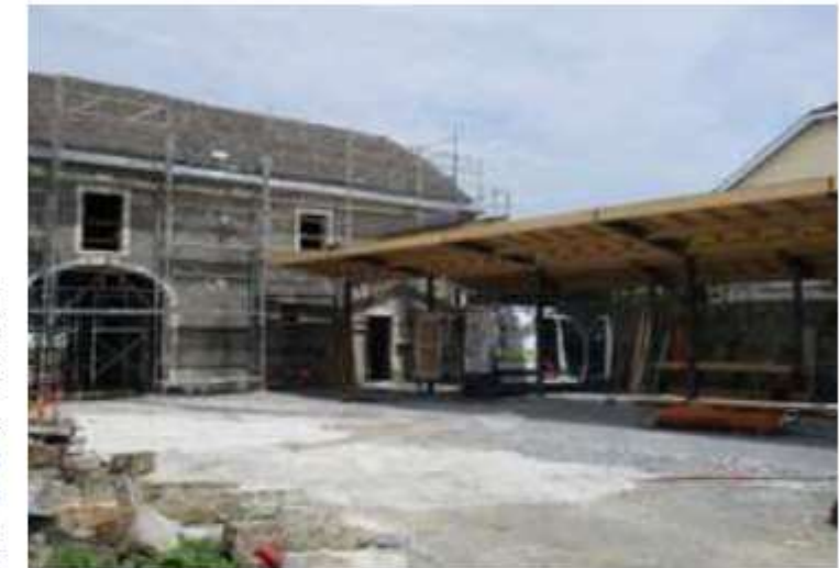
Le toit de la halle en voie de finition. © ALAIN GREGO
