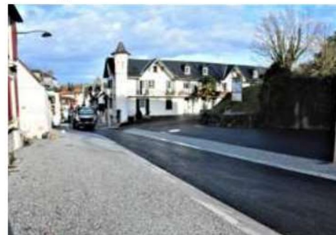
La côte Saint-Martin débarrassée des fils aériens et habillée de son nouveau revêtement.
