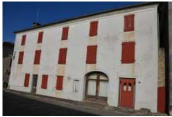
L'attribution des marchés a été validée pour les travaux de la boulangerie de Labastide-Villefranche. © ANNELEJANPILATE
