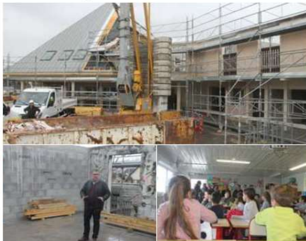
Les travaux ont commencé depuis décembre 2018 : le maire espère que ses écoliers pourront quitter les bungalows de l'école temporaire en octobre. ega
