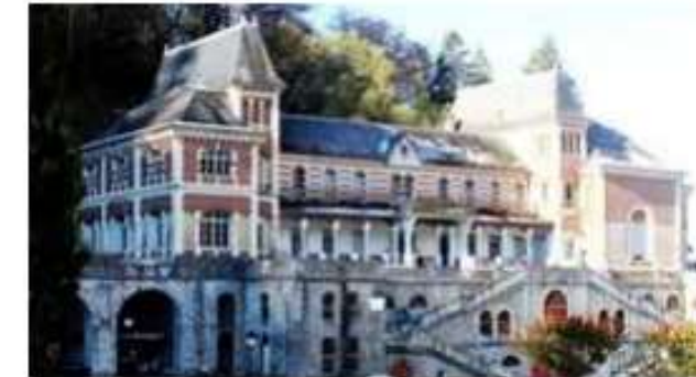
Le casino de la commune date du XIX e siècle. © ARCHIVES HP
