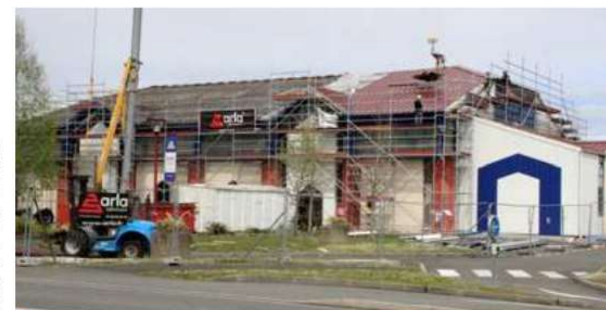
Les travaux de réhabilitation de la salle polyvalente se poursuivent et sont dans les délais. ©BERNARD DELLE
